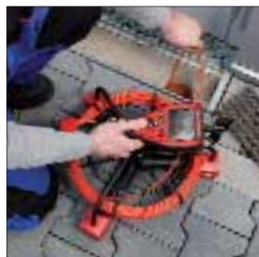
Обследование ливневых труб
