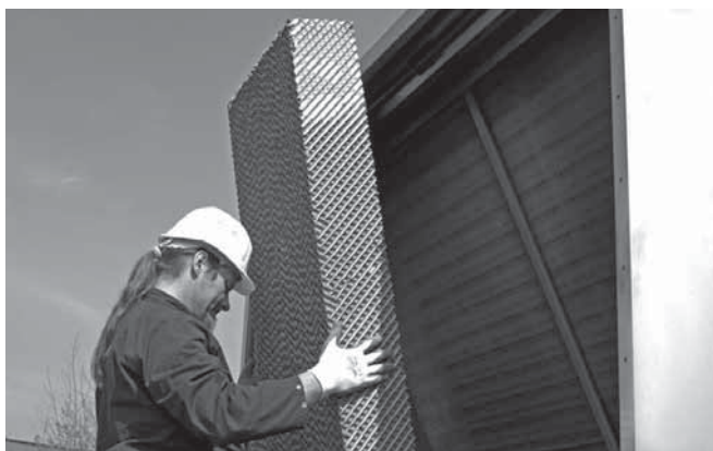
Рисунок 21: Снятие предохладительного материала
