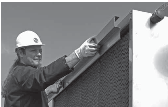
Рисунок 19: Снимите верхнюю пластину
