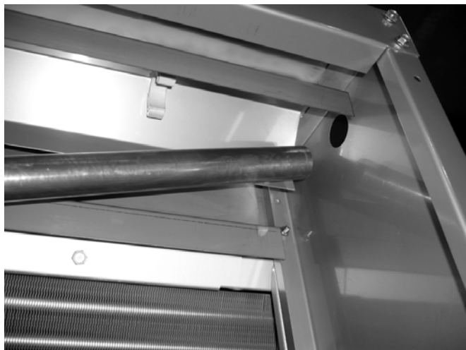
Рисунок 13: Установка медной трубы подачи воды
