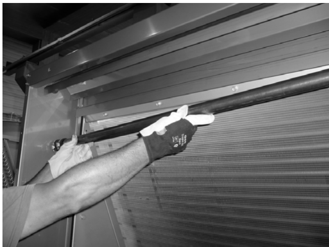
Рисунок 9: Извлеките медную трубу подачи воды
