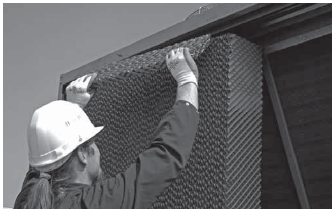
Рисунок 20: Извлечение водораспределительных панелей
