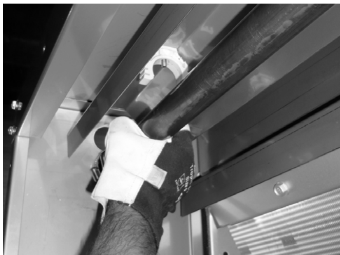
Рисунок 8: Высвободите медный коллектор из пластиковых держателей
