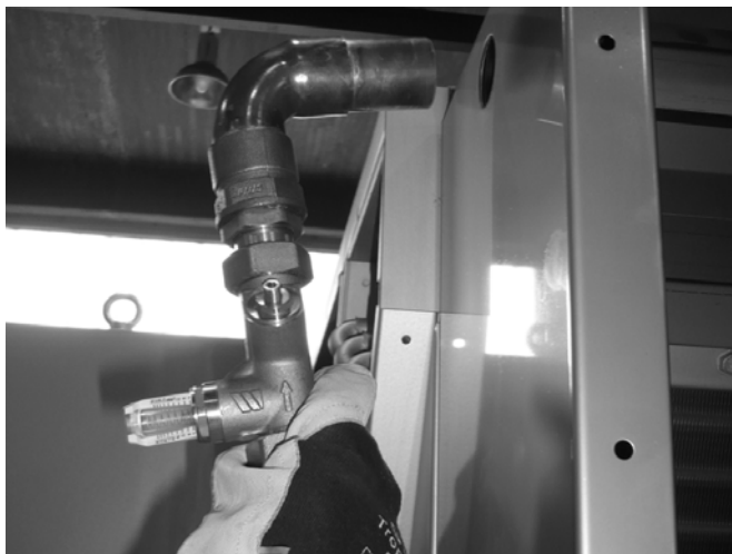
Рисунок 15: Узел подачи воды
