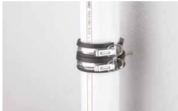
Рис. 86 Шумопоглощающий хомут в смонтированном состоянии
