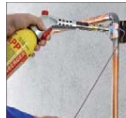
Пайка мягким припоем при монтаже системы отопления
