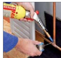
Пайка при монтаже системы подачи газа
