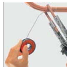
Нагрев места пайки без использования пламени
