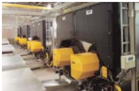
Четыре котла с двумя жаровыми трубами UNIVERSAL ZFR для производства насыщенного пара в параллельном режиме и режиме эксплуатации с одной жаровой трубой
