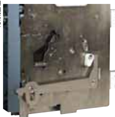
Блокировка дверцы при вкваченном аппарате
