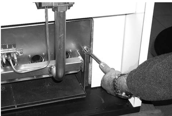
рис. 10 - Развинтите гайки крепления камеры сгорания
