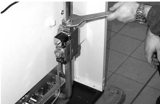
рис. 9 - Открутите гайку крепления газового клапана
