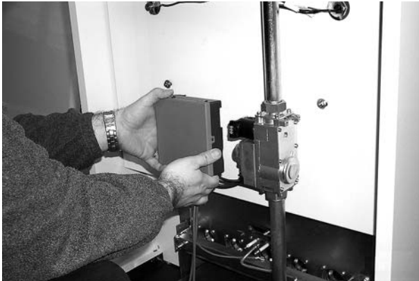
рис. 8 - Снимите блок управления
