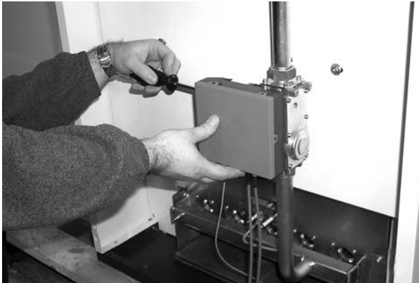
рис. 7 - Открутите два винта крепления блока управления
