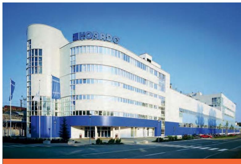
Главный производственный завод KORADO, a.s. является современным европейским заводом по производству радиаторов и отопительных устройств, и здесь же расположен центральный офис компании. Технологическое оборудование и производственные площади в 30 000 м 2 обеспечивают компании KORADO, a.s. все возможности для дальнейшего роста и развития.
