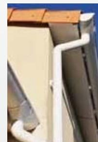
Водосточный желоб и изогнутая воронка Vodalis обеспечивают оптимальную водопропускную способность.
