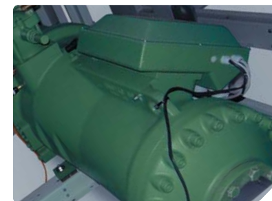
Полугерметичный винтовой компрессор
