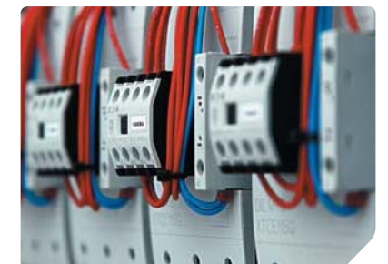
Защита компрессоров от перегрузки
