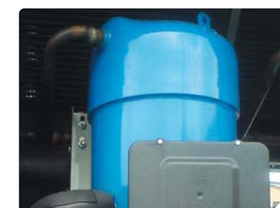
Высокоэффективный спиральный компрессор
