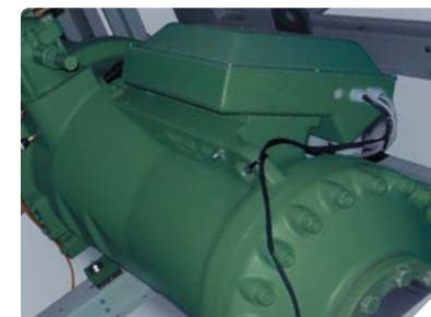
Полугерметичный винтовой компрессор
