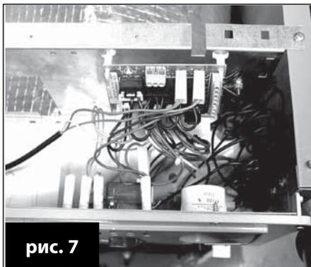
Котел оснащен контактом для подключения трехполюсного сетевого кабеля и соответствующим зажимным устройством для предотвращения разрыва.
