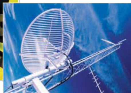
ТВ и радио приемная станция
