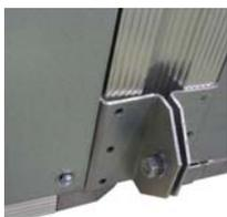
Dans le cas contraire, les caissons sont équipés de tire-flancs extérieurs. Assembler les tire flancs avec un boulon freiné.
