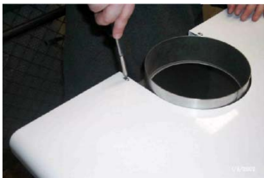
Рис. 3 – Отвинтите 2 самонарезных винта, удерживающих крышку котла.
